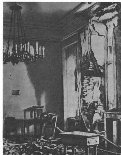
Разрушение в Николаевском дворце в Кремле в дни октябрьских боев. Москва. 1917.
